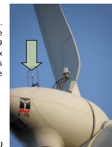
Figure 113 : Signalisation lumineuse sur une éolienne ENERCON (Source : IE)
